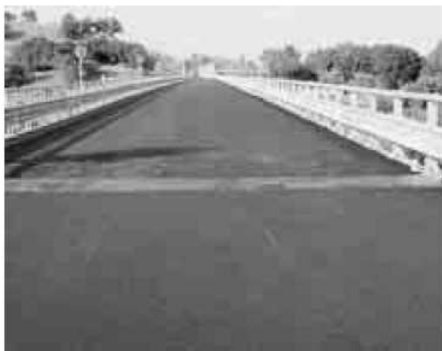
LA STRADA CHE UNIRÀ CALATABIANO ALL'AUTOSTRADA [DI GUARDO]
