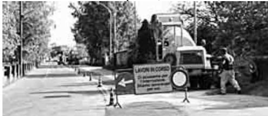
I LAVORI PER LA REALIZZAZIONE DELLA CONDOTTA
